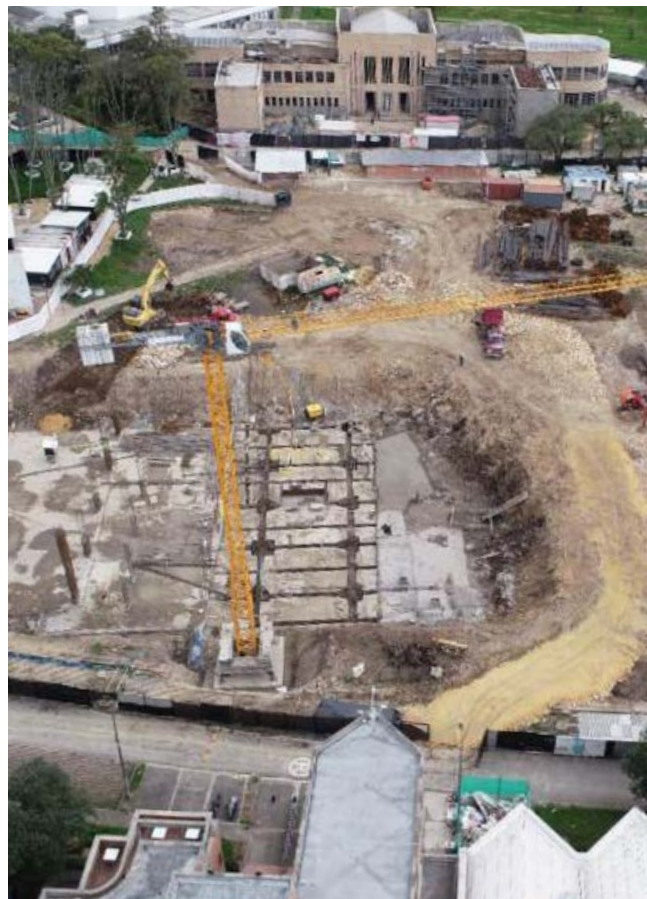
▲ Foto: Construcción Nuevo Edificio para las Artes. Sede Bogotá. DODF-Dirección de Ordenamiento y Desarrollo Físico.
